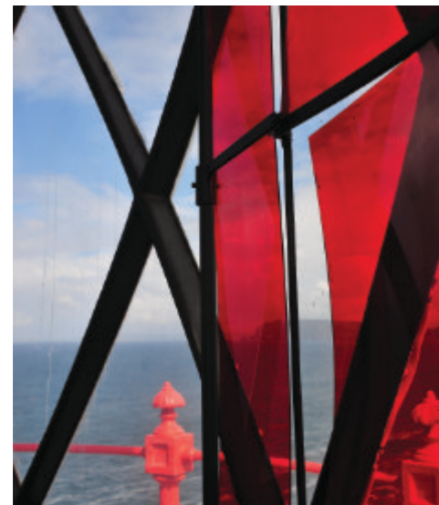
Aufnahme aus der Laterne des Leuchtturms, die Färbung der Verglasung für den roten Sektor ist deutlich sichtbar.
