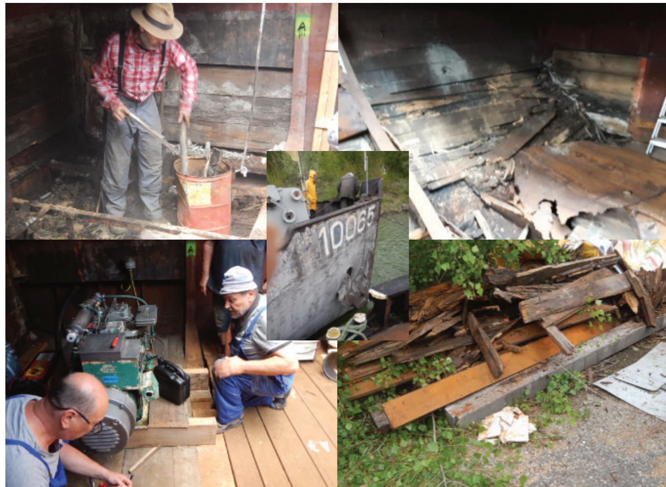
Zur Veranschaulichung der vielfältigen Arbeiten an Güterkahn und an der FHS-Lände (im Uhrzeigersinn von links oben): Entfernen von Ladungsresten und vielfältigem, nicht identifizierbarem Material aus den Laderäumen; Schadensbild an der hölzernen Wegerung, welche noch vielfach mit rostigem Eisenblech abgedeckt ist; Lagerung des ausgebauten Abfallholzes an der Lände; Einbau eines grundüberholten Stromgenerators im Laderaum 4; In der Mitte der Bildauswahl: Bugsektion des GK 10065
