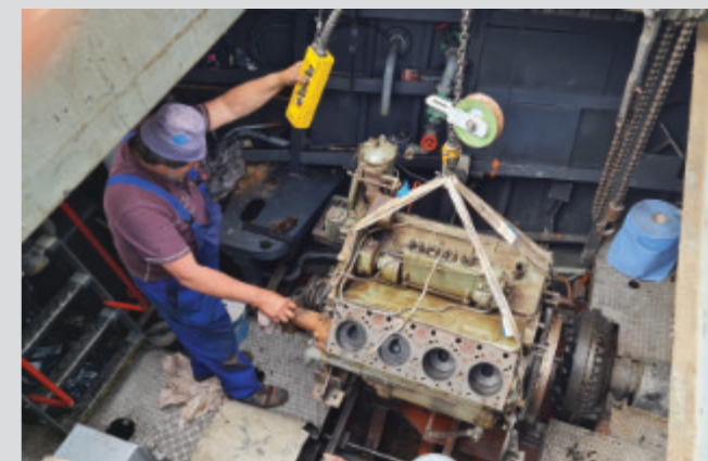
Bild 5: Nun war die »neue« Antriebsmaschine bereit, um – wiederum mit dem Bordkran des Schleppts – in die richtige Position im Maschinenraum des längsseits verhefteten GNOM gehoben zu werden. (26.05.2023, Bild: Edgar Wilhelm).
