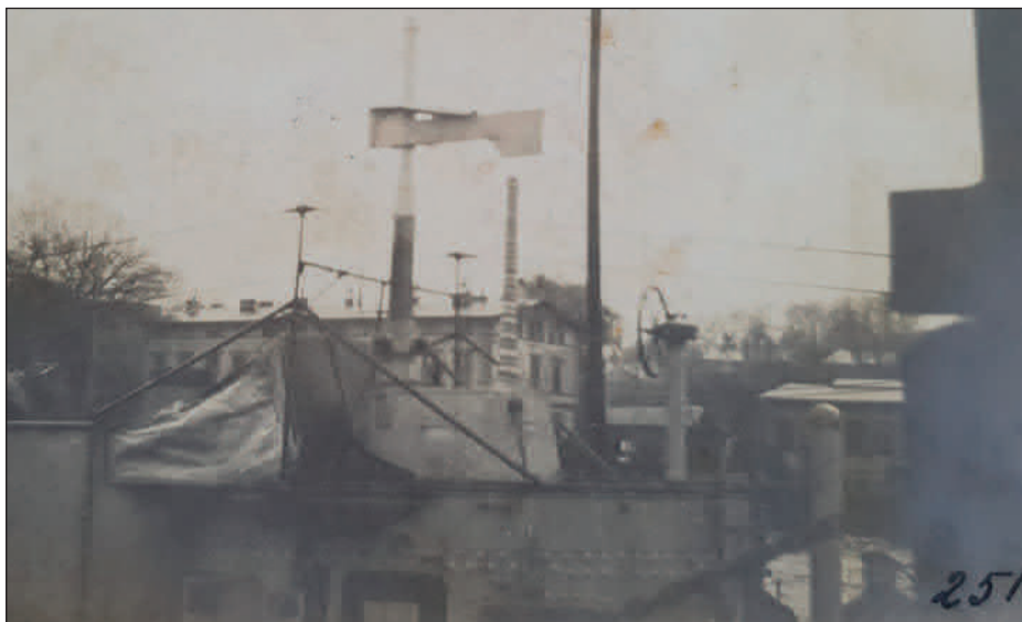
Abb. 12: Unterseebootinspektion Versuch: Schwimmer montiert am Periskop des deutschen Unterseebootes U-16 in Kiel im November 1915
