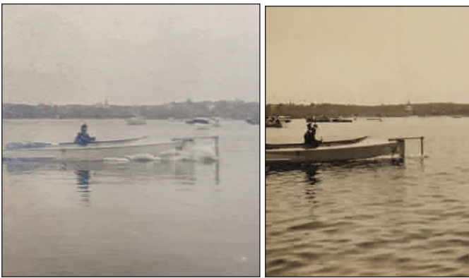
Abb. 10: Versuche am Wannsee in Berlin im Juni 1915. Links mit rundem Rohr, rechts mit dem tropfenförmigen Schwimmer
