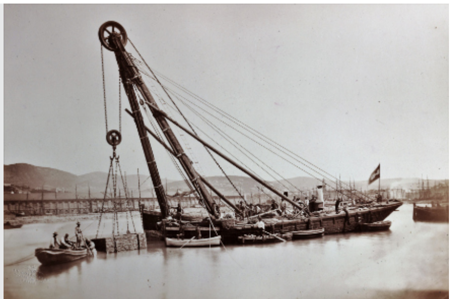
Schwimmkran beim Verlegen der gemauerten Blöcke, die mit Hilfe von Tauchern (am Bild links im Wasser) positioniert wurden
