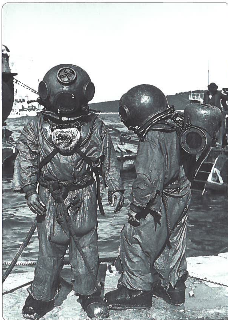
Taucher der k.u.k. Kriegsmarine in Ausrüstung. Helm aus Kupfer, Schuhe und Brust mit Bleigewicht beschwert. Sehr seltene Aufnahme
